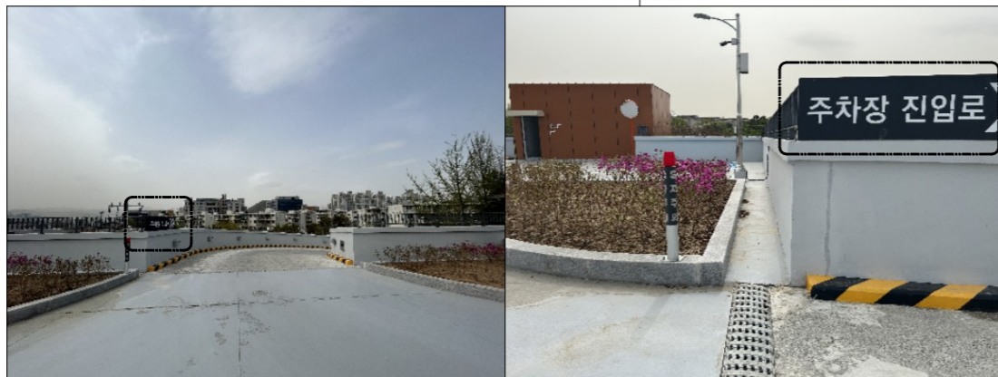
주차장 진입로 표지판에 걸리지 않도록 구조 하지를 설치
